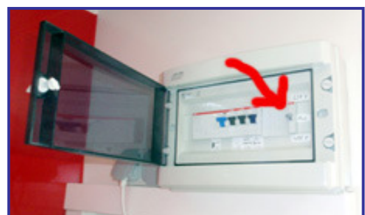
Umschalter Sicherungskasten
