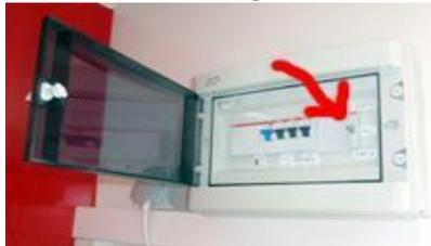
Je nach verwendeter Stromart muss der Schalter auf 230V oder 400V umgeschaltet werden. Liegt 400V an, können dennoch Geräte mit 230V betrieben werden. Eine Kabeltrommel (Kabel muss immer komplett abgerollt werden) für Kraftstrom (40 m), ein Verlängerungskabel für Kraftstrom (10 m), sowie ein Adapterstecker sind im Anhänger vorhanden.
